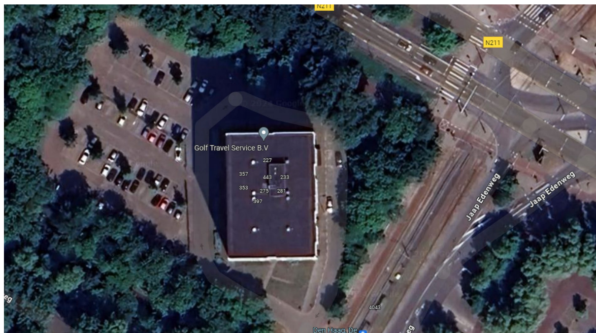
Figuur 2: Parkeerterrein Lozerlaanflat
